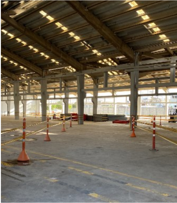
Sitio de instalación
