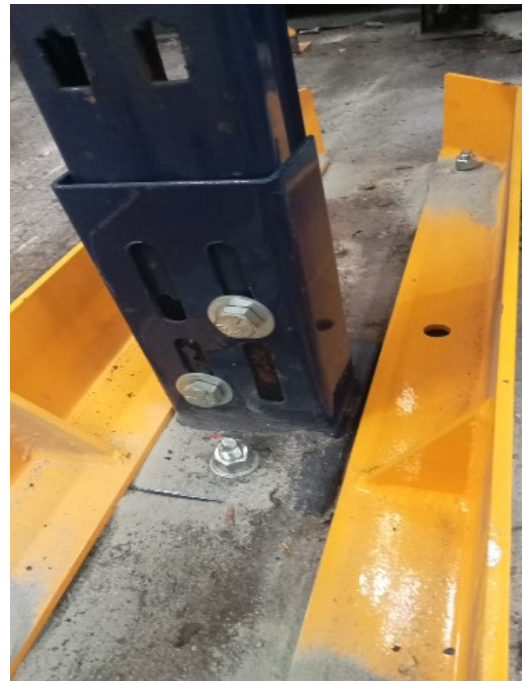
INSTALACION DE NIVELADORES
