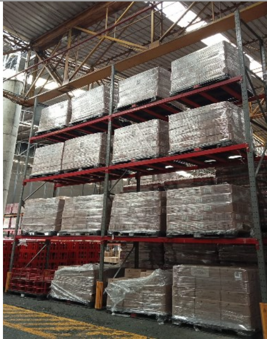
CAMBIO DE VIGA SOPORTE
