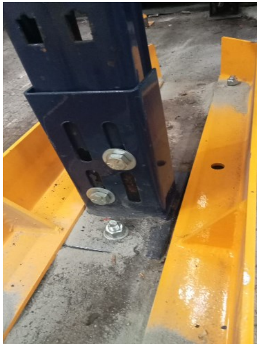
INSTALACION DE NIVELADORES
