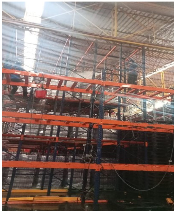
LAVADO DE ESTRUCTURA
