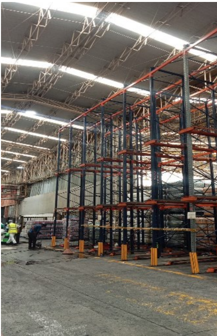
LAVADO DE ESTRUCTURA
