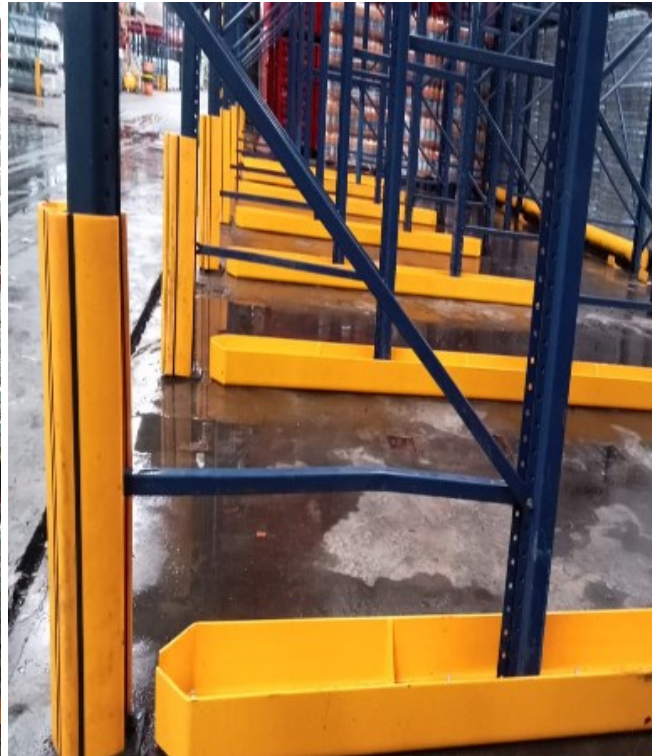
CAMBIO DE OMEGAS POR RIELES OMEGA
