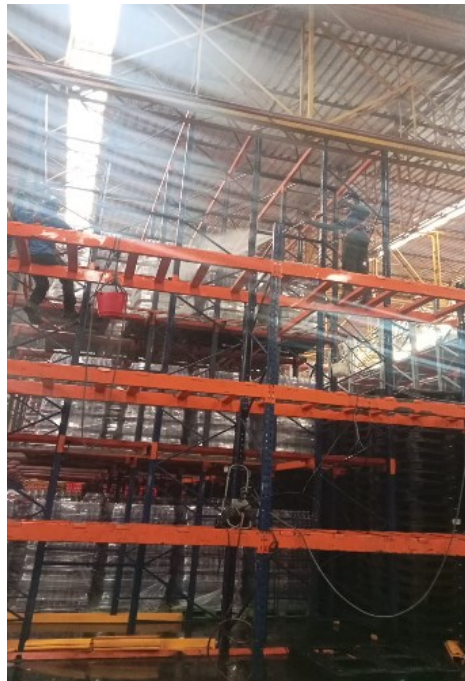
LAVADO DE ESTRUCTURA
