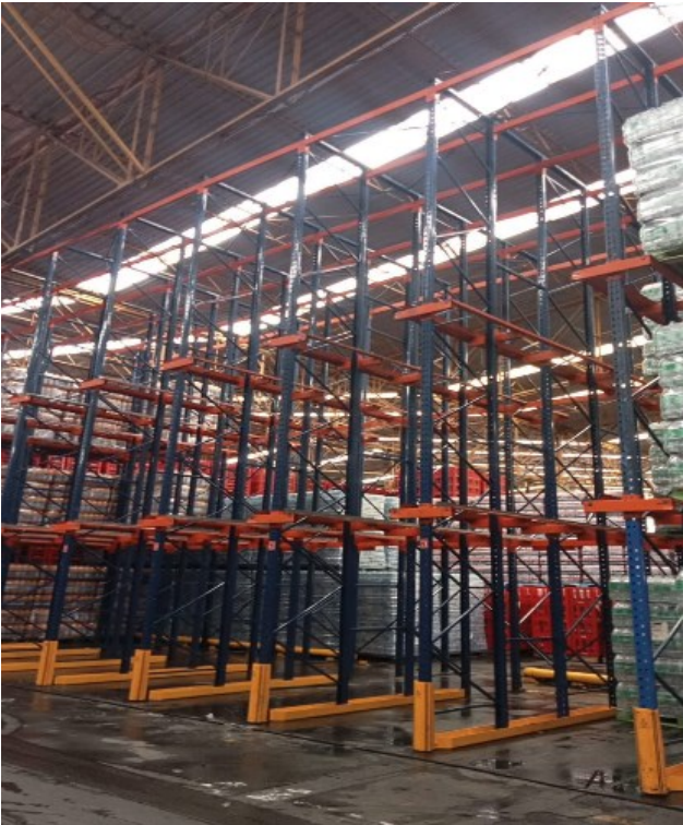
LAVADO DE ESTRUCTURA
