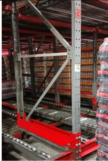
TUNEL DE ARMADO CAMBIO DE PUNTAL
