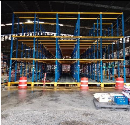
BLOQUE 5 LAVADO DE ESTRUCTURA
