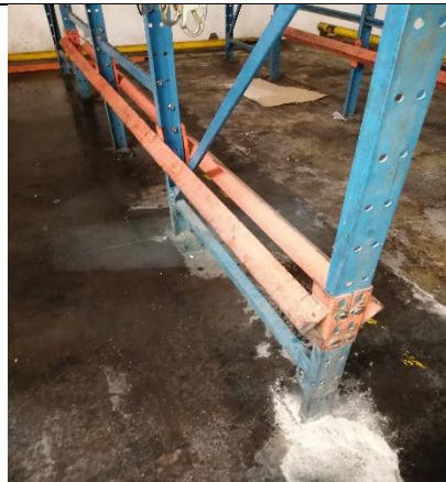
BLOQUE 2 ANCLADO DE LA ESTRUCTURA
