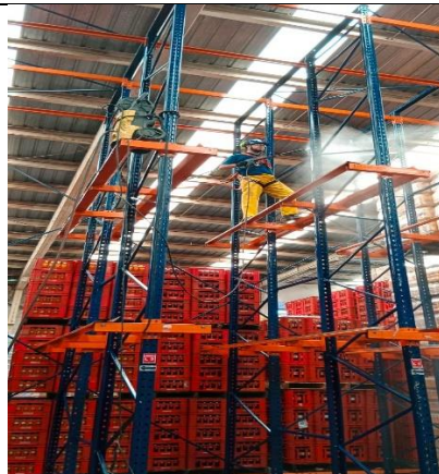
BLOQUE 2 LAVADO DE LA ESTRUCTURA
