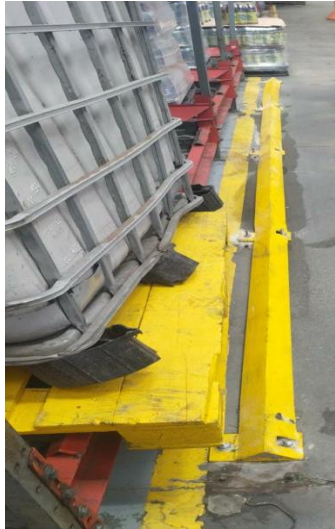
protectores de piso instalados y pintados
