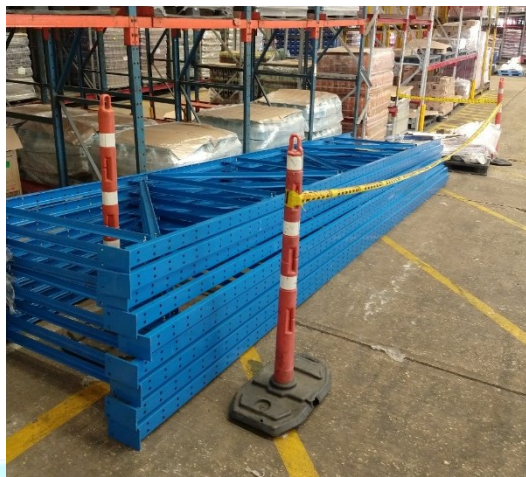
Bloque 3 Armado de bastidores
