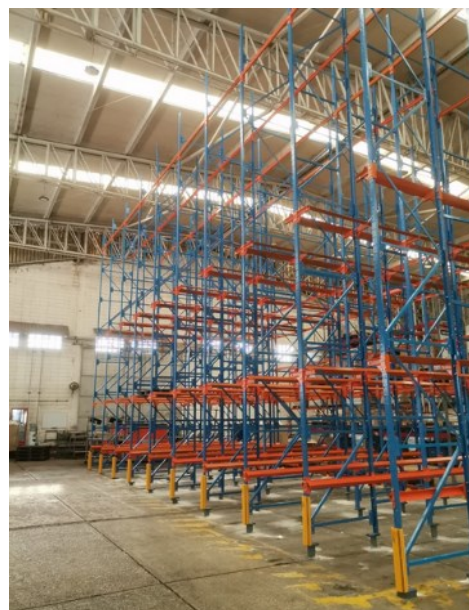
Estado final 9 calles
